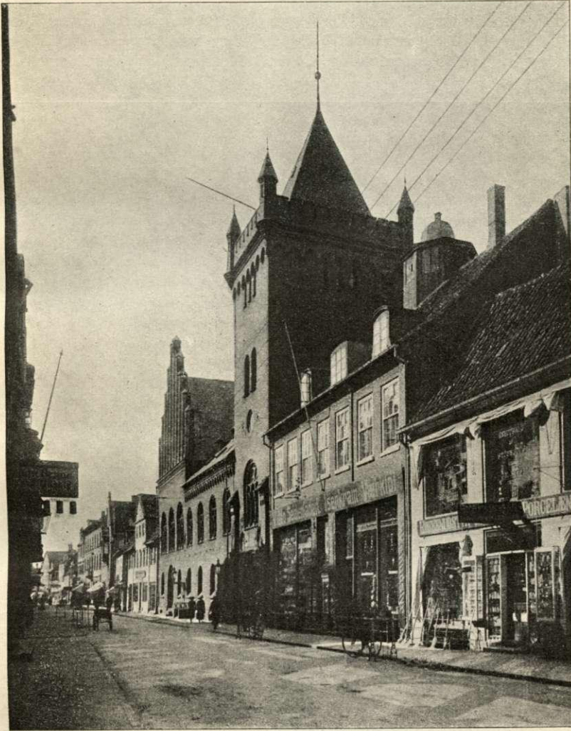
Stengade med Raadhuset.
