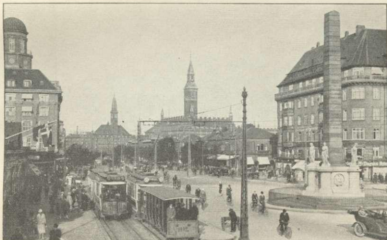
Vesterbrogade med Frihedsstøtten.
