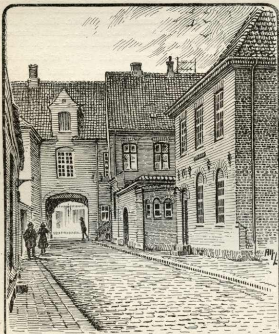
Bygaardsstræde med Folkebiblioteket.
